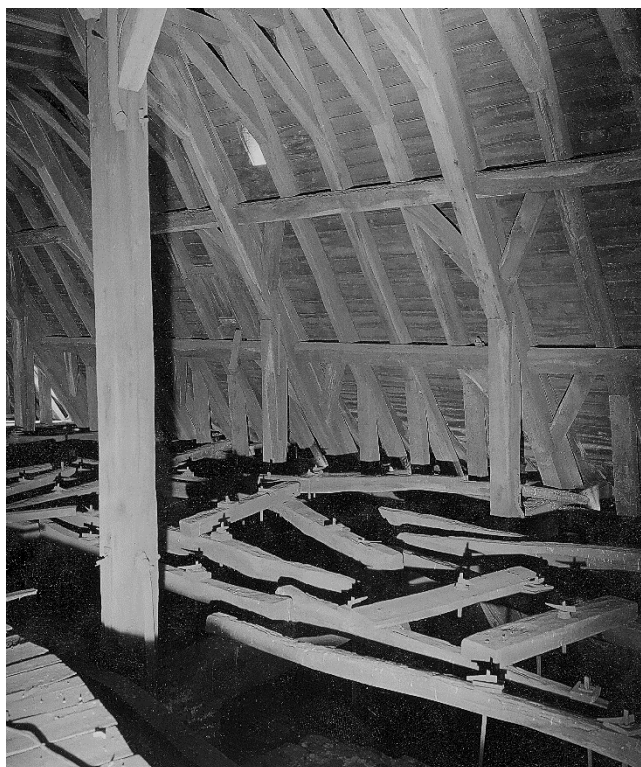
Ancien système de suspension des voûtes (aujourd'hui disparu). Eglise Saint-Jacques, Liège, date indéterminée (auteur anonyme, cliché B164878, extrait de la photothèque en ligne © KIK-IRPA, numéro d'objet 10072925).
